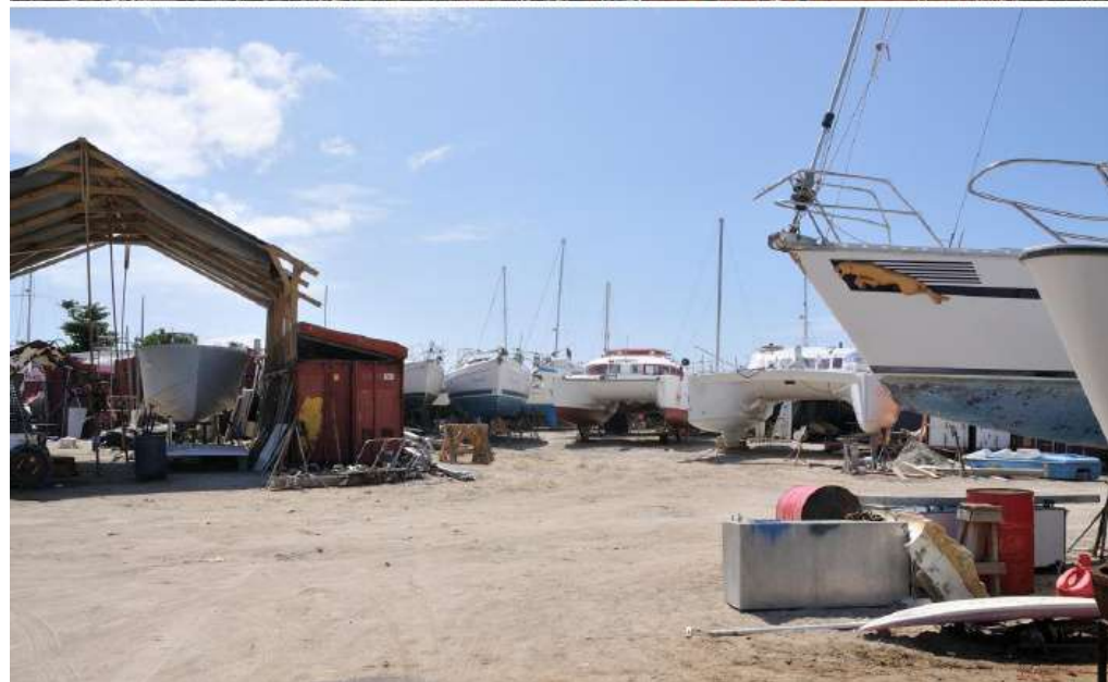
Figure 42 : Chantier Geminga quelques jours après le passage d'Irma, puis en mars 2018 (source Métimer)
