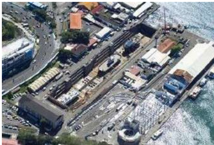
Figure 39 : Forme de radoub 180m Fort-de-France (source ENA)
