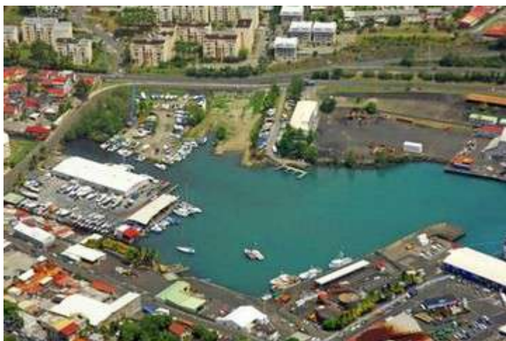
Figure 46 : Aire de carénage Fort de France (source Carenantilles)
