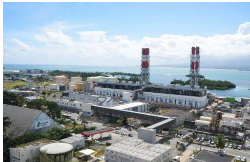
Figure 109 : Pointe Jarry (crédit photo : EDF)
