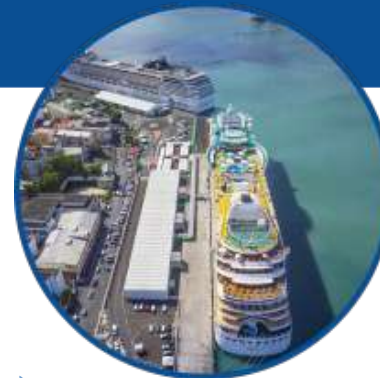
| Grand Port Maritime (Guadeloupe) © Guadeloupe Port Caraïbes
